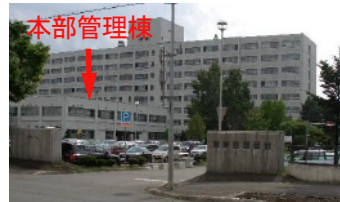
本部管理棟 リハビリテーション病院側からの入口。写真左中央部分の2階建ての建物が本部管理棟です。
