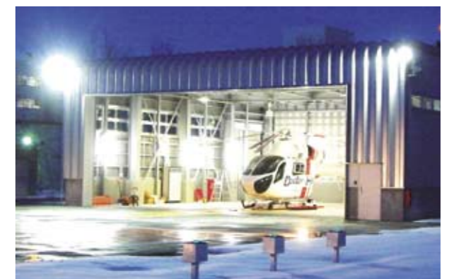
旭川医科大学敷地内に造ったヘリポートと格納庫
